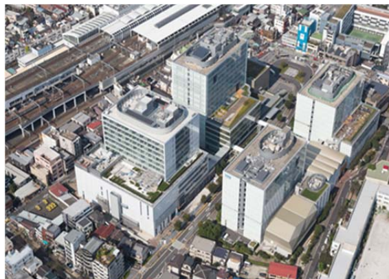
【建設進捗状況（H28. 10. 23現在）】
