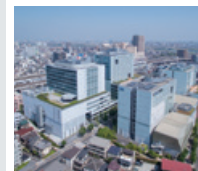
東京千住キャンパス・進化 2012(平成24)年、北千住駅徒歩1分に開設。地域に開かれた最新の環境、防災技術を整備。2017(平成29)年4月に5号館を開設。
