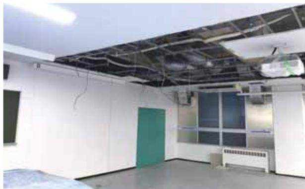
大学では施設設備のメンテナンスを夏季休業中に行うことが通例で、今年は、教室に換気設備を導入する工事を行いました。これまで換気設備がない教室では、空調と窓・ドアの開放、サーキュレーターを設置により室内を換気していました。これからは、建物付帯の換気設備も加わり、学生の皆さまにはコロナ禍においても、さらに安心安全かつ快適なキャンパスライフを送っていただけます。(理工学部事務部 藤田)
