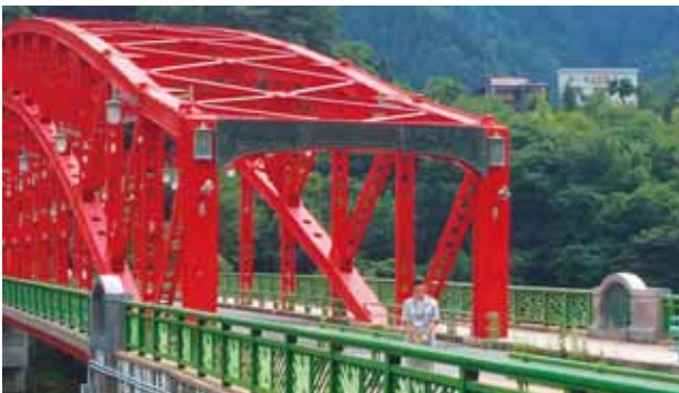
インターンシップで見学した奥多摩湖の峰谷橋
