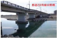
特徴:①山中の急流により護岸の侵食、橋脚の洗堀による被害が発生した。②中流にあたる日野橋でも洗堀が発生した。③鉄道橋でも洗堀被害が発生しているとのことである。 課題:①侵食発生箇所の予測と対策は? ②洗堀による橋梁被害の対策は? ③台湾での対策事例に学ぶ必要あり。
